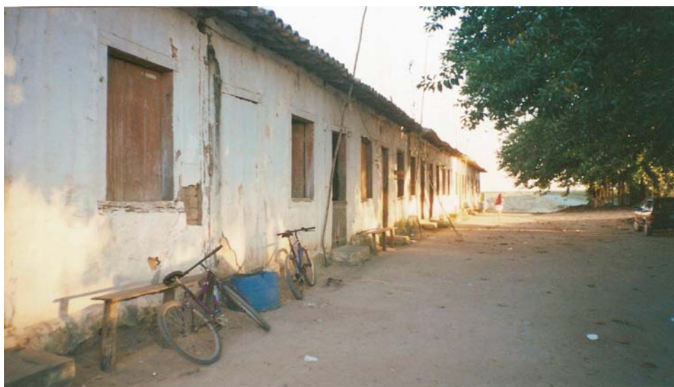
Fig. 7 – Vista parcial do conjunto de casas da antiga senzala de Machadinha.
