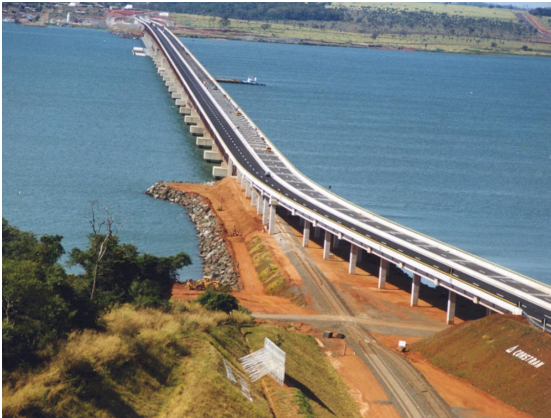
Figura 43 – Ponte rodoferroviária sobre o rio Paraná
