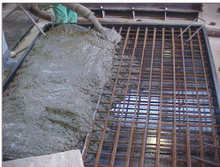
FIGURA F.4– Lançamento do concreto na forma
