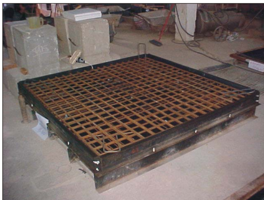
FIGURA F.2 – Forma montada para concretagem
