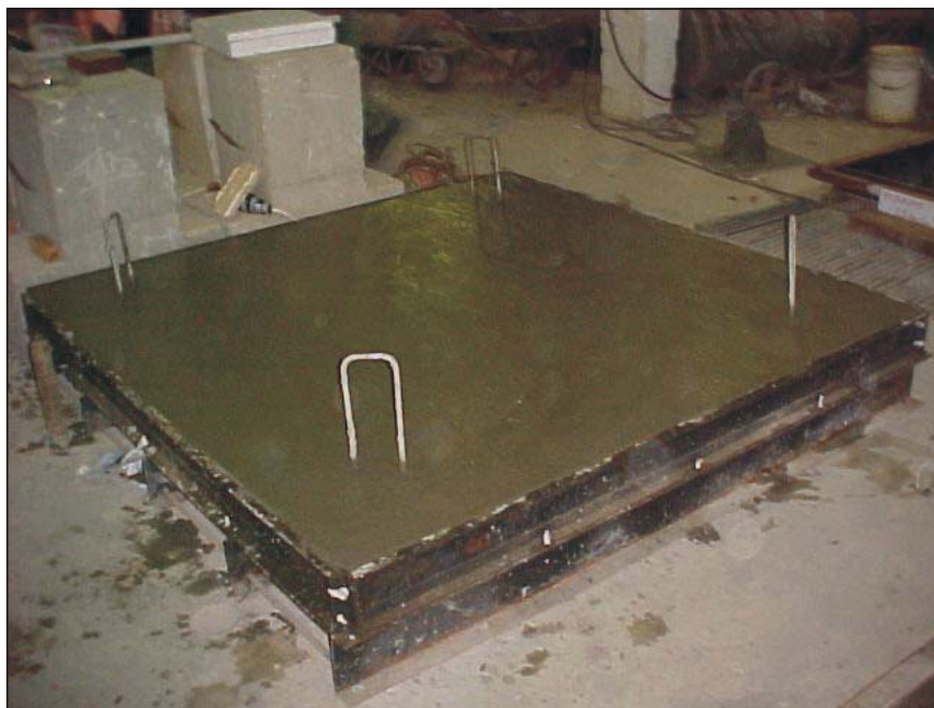
FIGURA F.5 – Laje concretada
