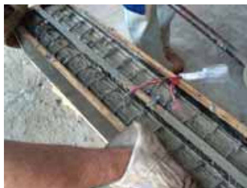
Figura 6.44 – Concretagem das vigas: adensamento.
