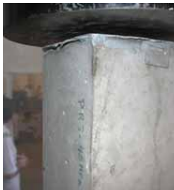
Figura 6.34 – Regularização da superfície com massa plástica.
