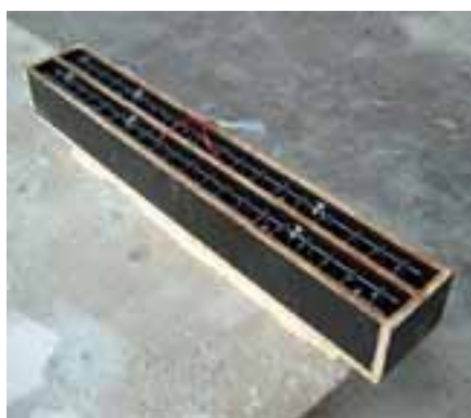
Figura 6.41 – Fôrma de madeira das vigas. Mesa vibratória.
