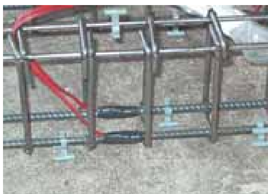
Figura 6.43 – Detalhe dos extensômetros colados no aço – barras inferiores.
