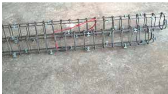
Figura 6.42 – Armadura das vigas.
